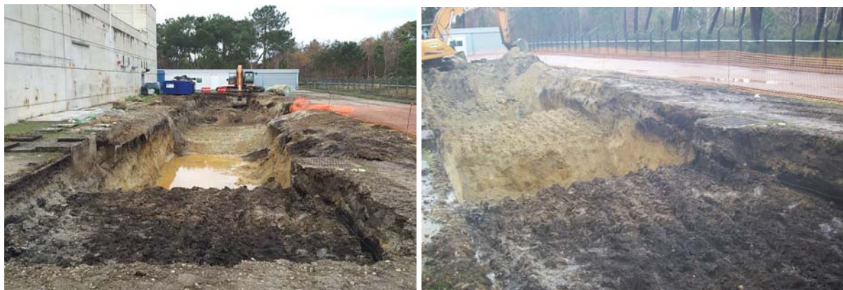
Photos 5 : Terrassement zone espace vert – ancienne rétention
