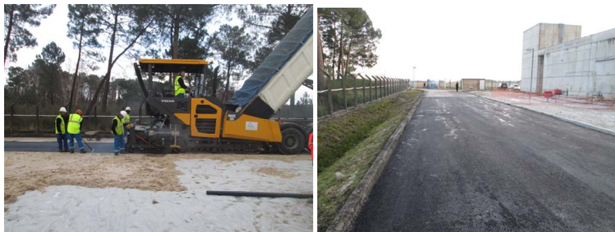
Photos 10: Réfection de voirie
