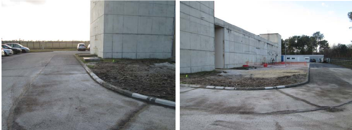
Photos 1 : Remplacement des bordures
