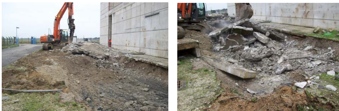
Photos 4 : Gestion des bétons
