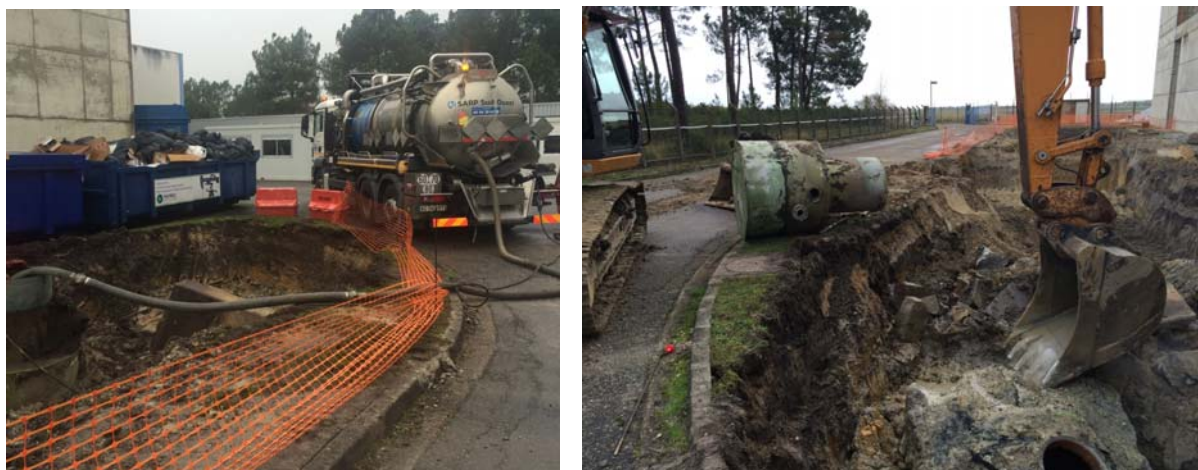
Photos 8 : Pompage et évacuation cuve et séparateur
