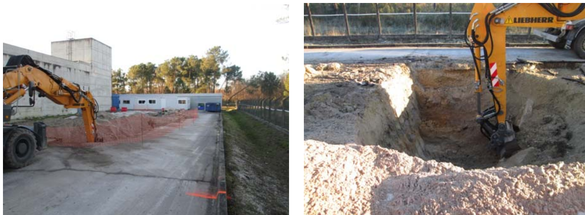
Photos 6 : Terrassement sous chaussée
